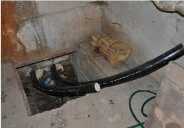
Tabivere korterelamute soojussõlmi; kaugküttetorustiku sisend ja kaev
