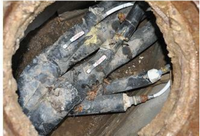
Tabivere korterelamute soojussõlmi; kaugküttetorustiku sisend ja kaev
