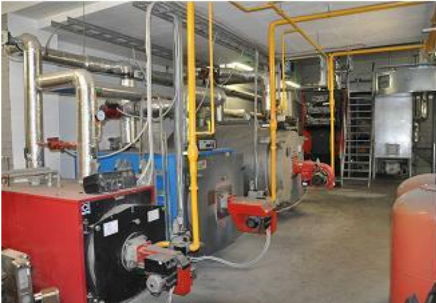
Tabivere katlamaja: gaasikatlad ja hakkepuidukatelseadmed
